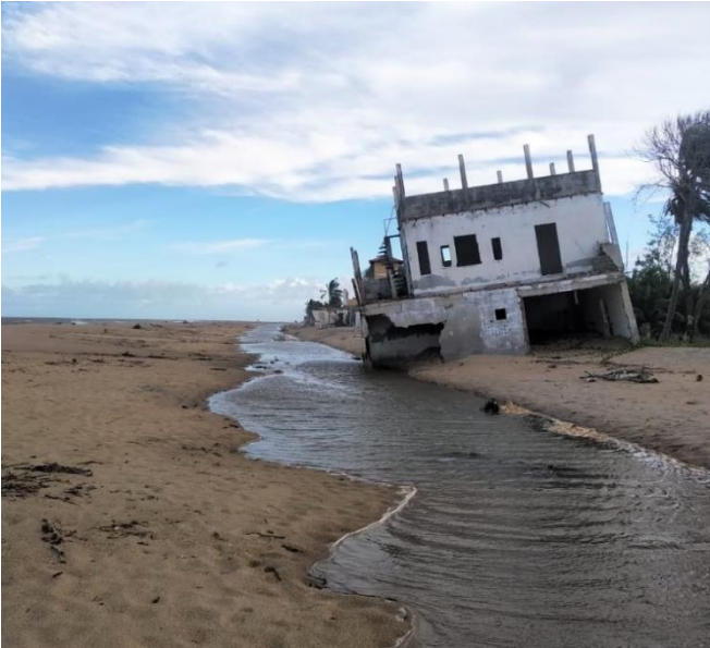
Figura 7. Erosão costeira na praia do mar moreno, Belmonte/BA. Foto: Luca Lämmle, 2021.
